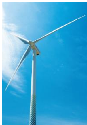
ハマウイング よこはましふうりょくはつでんしょ (横浜市風力発電所)
