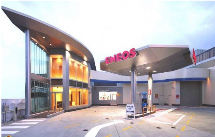
ENEOS横浜綱島水素ステーション
