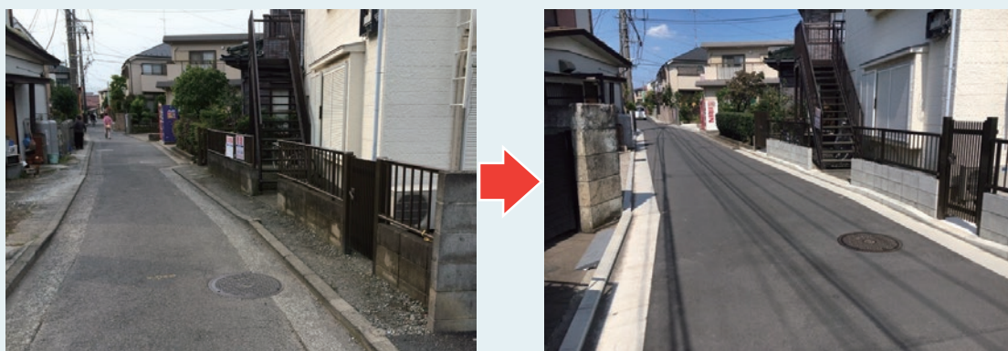
狭あい道路の拡幅整備
