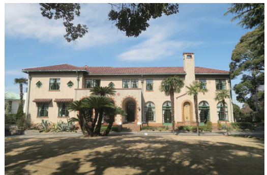
ベーリック・ホール
