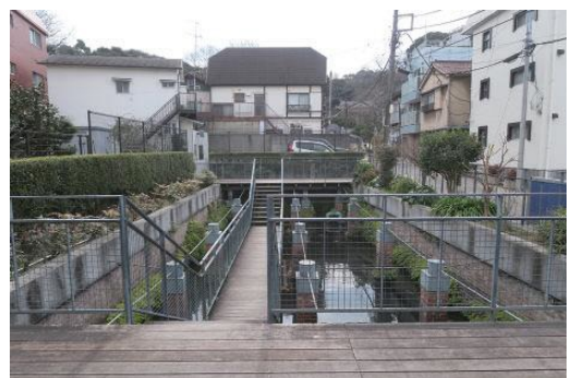
ジェラルール水屋敷地下貯水槽
