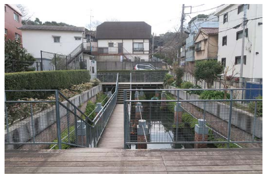
ジュラルル水屋敷地下貯水槽
