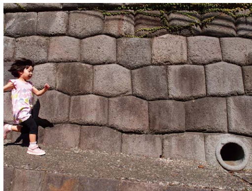
旧平沼専蔵別邸亀甲積擁壁
