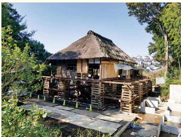
旧藤本家住宅主屋…横浜市認定歴史的建造物（平成4年（2002））、特定景観形成歴史的建造物（平成28年（2016））。建築基準法の適用除外により茅葺屋根の保全を図っている。写真は、復元に際しての揚屋工事。
