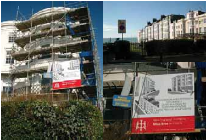
通常の不動産として改修・取引されている登録文化財：イギリス・ブライトン&ホーヴ市
