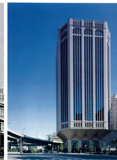
1993 大同生命大阪本社ビル
