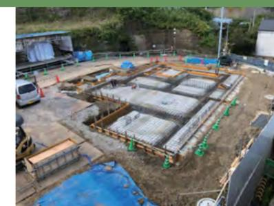
新設鉄筋コンクリート基礎（鉄筋配筋状況）
