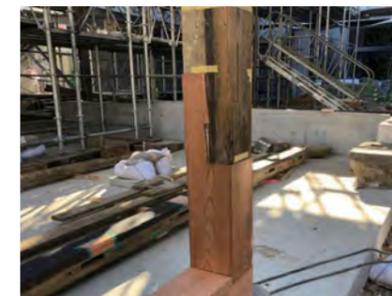
部材補修状況（根継ぎ柱）
