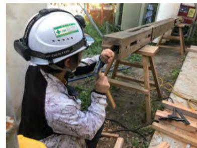
部材補修状況（柱材）
