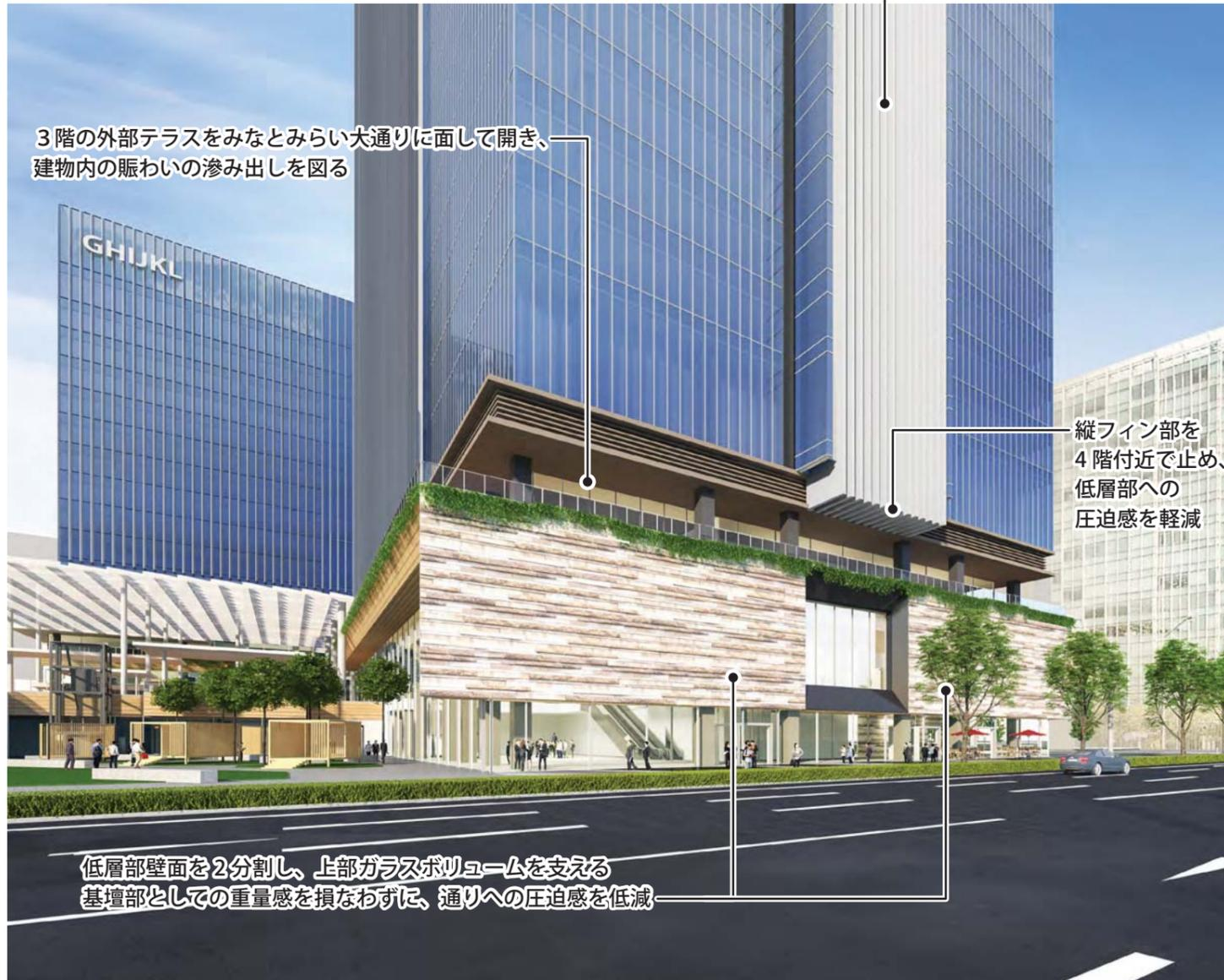
縦フィン部を4階付近で止め、低層部への圧迫感を軽減
