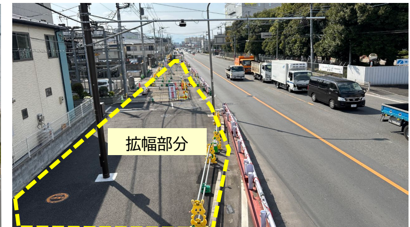
【目黒交番前交差点付近における拡幅工事の状況】
