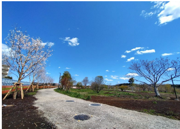
【整備中】公園の植栽・園路
