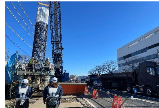
【橋りょう基礎杭の施工状況】
