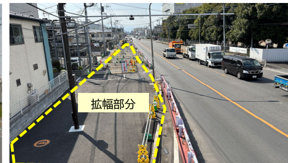
【目黒交番前交差点付近における拡幅工事の状況】
