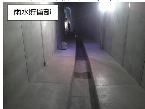
北側雨水調整池工事（C）
