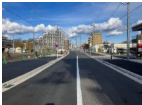
電線共同溝・道路拡幅工事（A）
