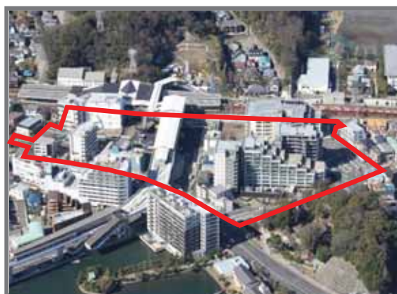
金沢八景駅東口地区 土地区画整理事業（完了）
