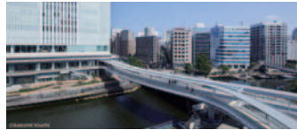
61 横浜市役所の水辺テラスとさくらみらい橋 (中区)
