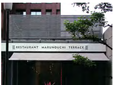
外壁デザインと合わせてルーバーで隠している例 (千代田区)
