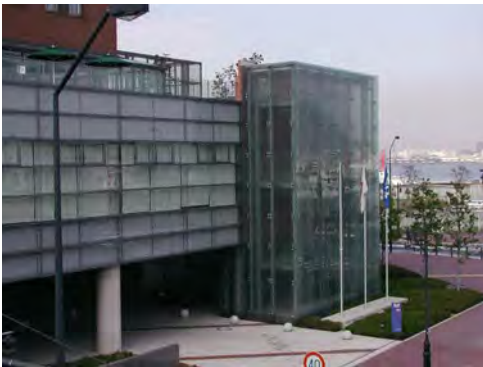
透過性素材によって軽快に仕上げつつ、美しく見せる外階段デザインの例（新港地区内）
