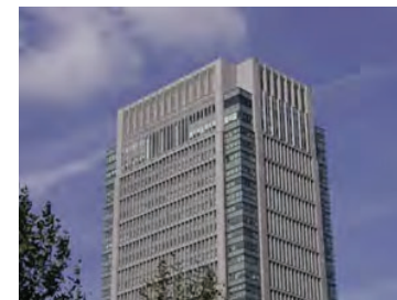
塔屋を建物と一体的にデザインした例 (千代田区)
