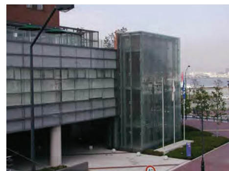
透過性素材によって軽快に仕上げつつ、美しく見せる外階段デザインの例 (新港地区内)
