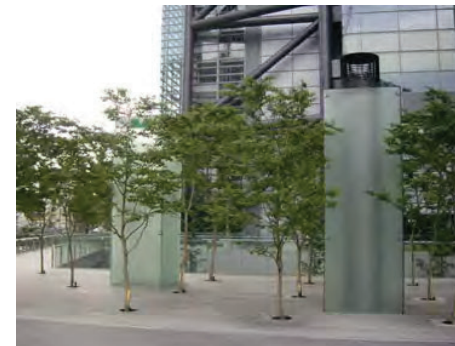
吸排気等を建物外壁と同様のガラスで修景した例 (港区)
