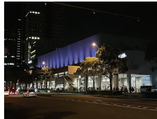
建物壁面を利用したイベント時の照明演出の例
