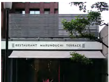
外壁デザインと合わせてルーバーで隠 している例 (千代田区)
