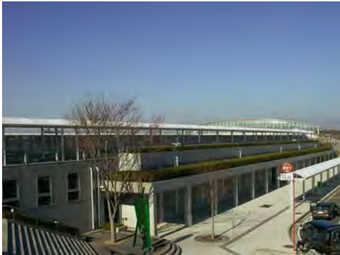
屋上緑化された駐輪場の例(石岡市)
