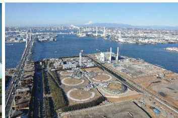
扇島 LNG 基地 (提供:東京ガス(株))
