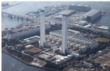
横浜火力発電所(提供:東京電力 フュエル&パワー(株))
