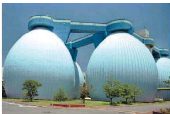
北部汚泥資源化センター
