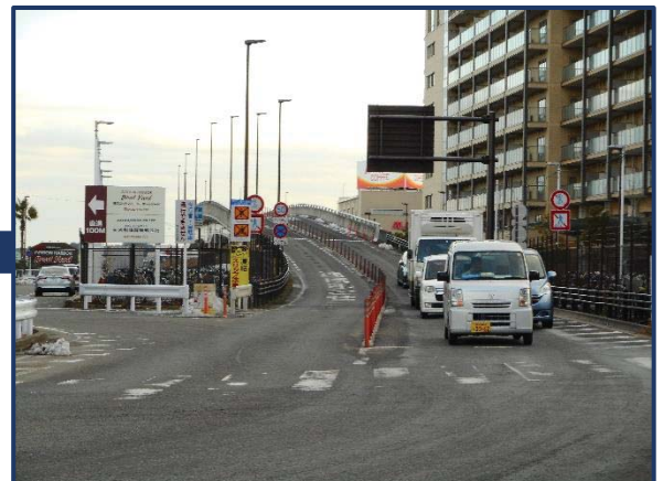
臨港幹線道路の暫定供用区間の状況(山内ふ頭)
