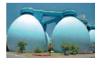
北部汚泥資源化センター
