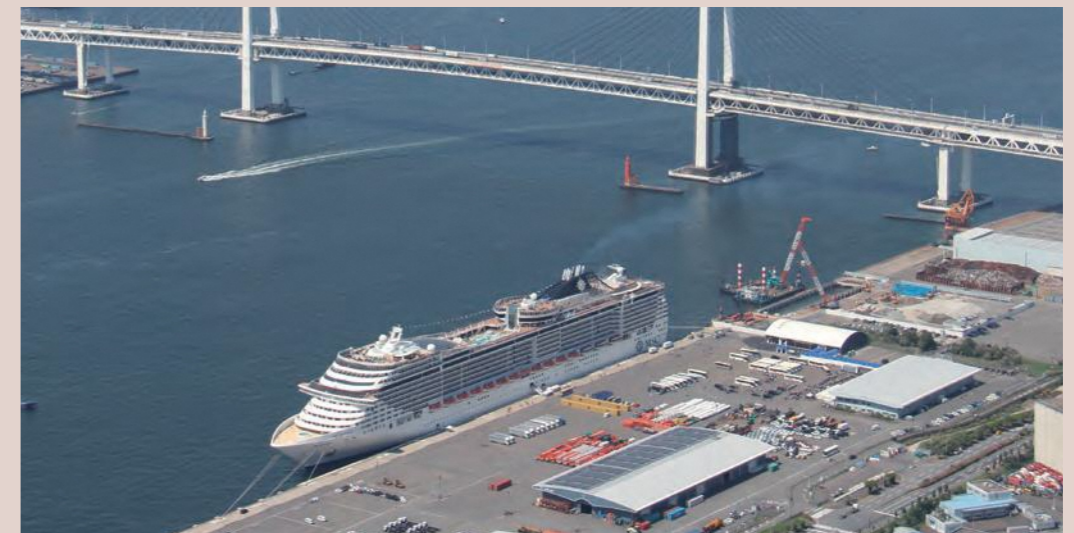
大黒ふ頭への大型客船寄港の様子
