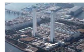
横浜火力発電所 (提供：東京電力フュエル&パワー(株))
