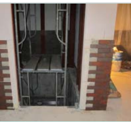
若葉台地区センターエレベータ設置工事中写真
