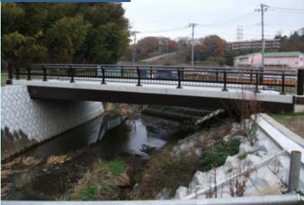
舞岡橋架替拡幅
