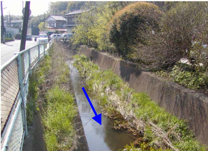
下流より舞岡橋 (平成16年4月撮影)
