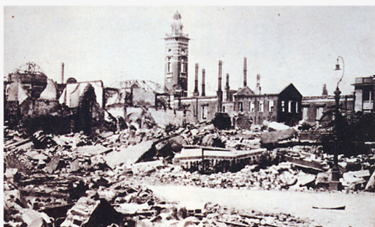
関東大震災の被害
