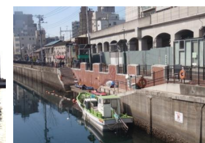
黄金町の高架下活用と併せて整備された船着場
