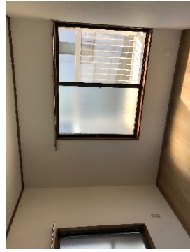
2階南東側洋室②
