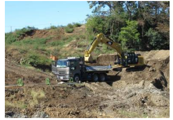
土砂搬出状況
