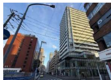
水町通りに面した共同住宅
