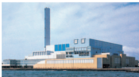
金沢工場(2001年4月稼働)
