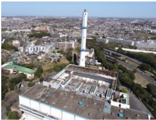
再整備する保土ケ谷工場
