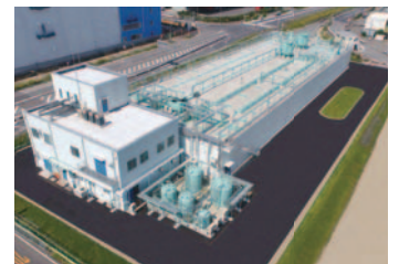
南本牧第5ブロック排水処理施設
