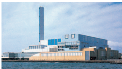
金沢工場(2001年4月稼働)
