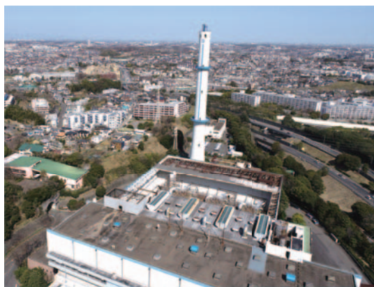
再整備する保土ケ谷工場
