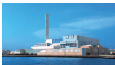
ごみ焼却工場
