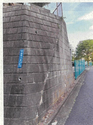
敷地内擁壁の一部
