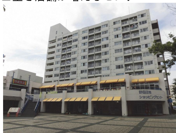
■ 空き店舗が増えるセンター
