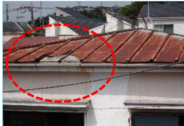
落下しかけの金属屋根材撤去
