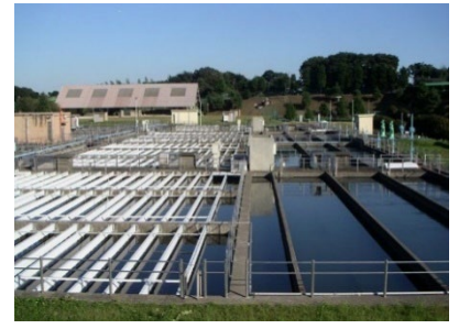
<小雀浄水場沈殿池>
