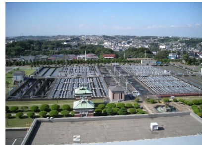
＜西谷浄水場沈殿池＞
