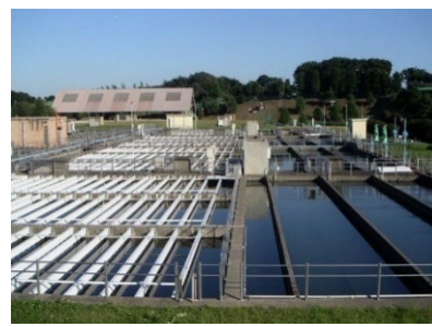
<小雀浄水場沈殿池>
