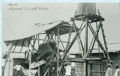
西谷浄水場築造に使われた日本初のコンクリート混和機(大正2年)
