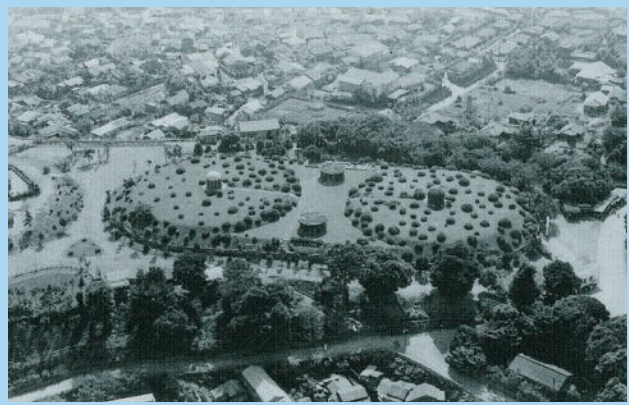
震災復興後の野毛山配水池 (昭和2年)
