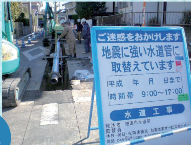
古くなった水道管を地震に強い管に取り替えています
