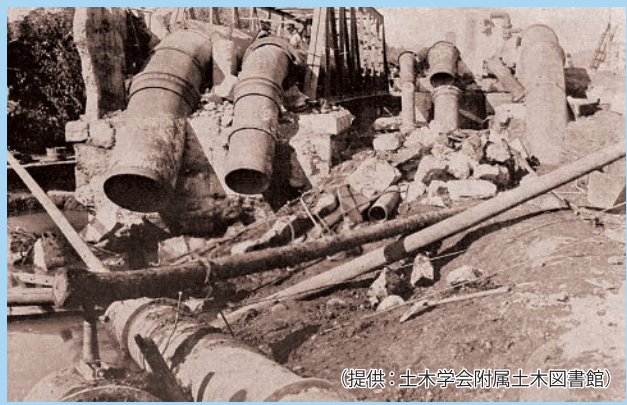
関東大震災で損壊した宮川橋水管橋 (保土ヶ谷区・大正12年)
