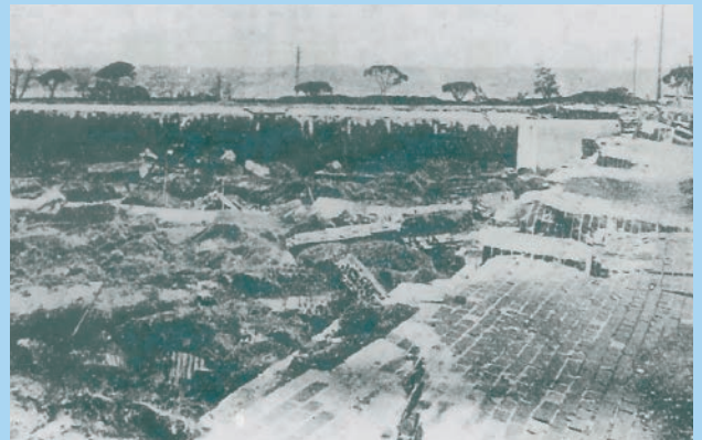
関東大震災で損壊した野毛山浄水場 (大正12年)
