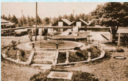
川井浄水場接合井(大正4年)
