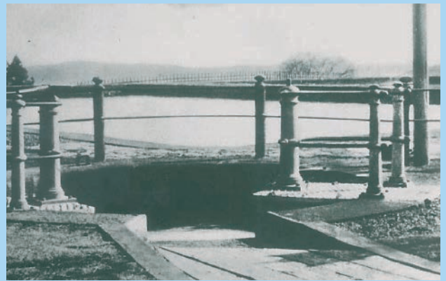
創設当時の野毛山浄水場 (明治20年)
