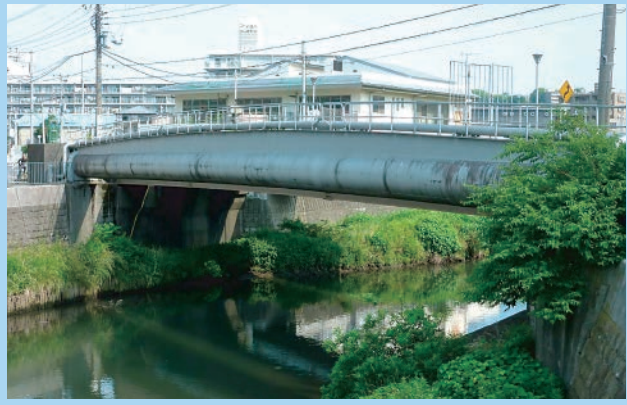
現在の宮川橋水管橋
