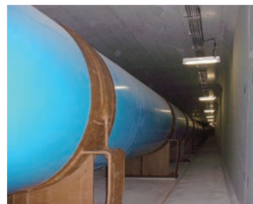
▲口径1,350mmの保土ヶ谷共同溝線
