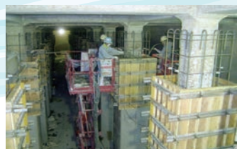
▲配水池の耐震化工事
