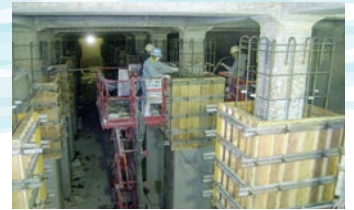
▲配水池の耐震化工事
