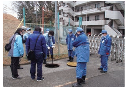
▲ 検針等受託事業者向け応急給水訓練 (恩田配水池)
