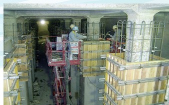
▲配水池の耐震化工事
