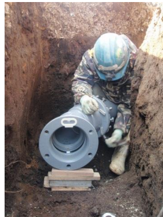
地震に強い管の布設の様子
