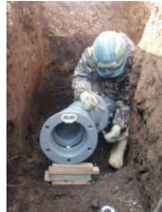
地震に強い管の布設の様子
