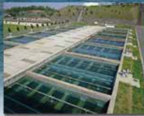
Nhà máy lọc nước
