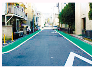
Después de colocar las franjas coloreadas para la seguridad
