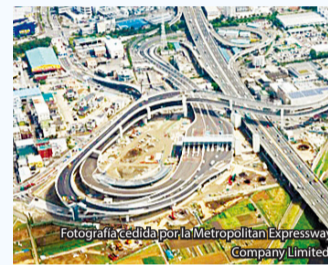
Entronque Kohoku de Yokohama
