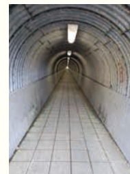
大原隧道内部
