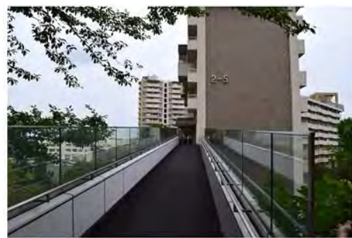
敷地内通路から中層階へのアプローチ
