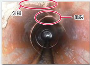
▲老朽化した下水道管内部の様子
