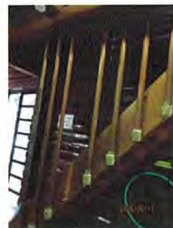
手すりの補修
