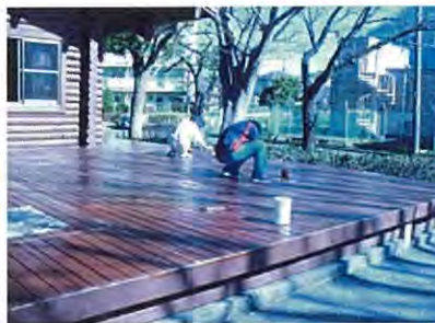
デッキの塗装
