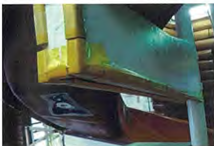
養生ゴムの貼り付け
