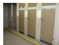
化粧室の段差に色をつけて判り易く
